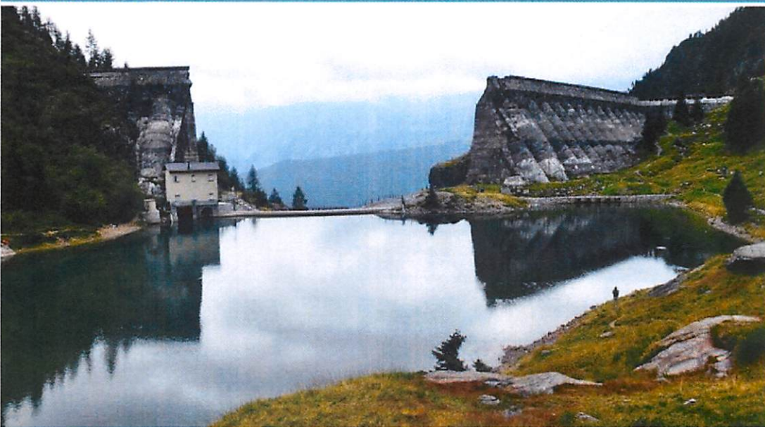
Una suggestiva immagine di quel che resta della diga del Gleno che la mattina del 1° dicembre del 1923 improvvisamente crollò causando un'immensa tragedia che sconvolse la Valle di Scalve e la Val Camonica. La foto è del nostro lettore Mauro Bignotti
